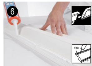
**Apply glue in V-Fix over the entire length of profile** | Applicare il collante su tutta la lunghezza nel solco a V | Aplicati adezivul pe toata lungimea profilului in V-Fix | Naneste lepidlo v tubě po celé délce profilu | Aplique a cola sobre toda a sanca utilizando o canal V-Fix
