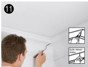
**Remove excess glue in joints after max. 1 hr, repeat after 2-3 hours** | Rimuovere il collante in eccesso prima dell'indurimento, 1 ora max. e ripetere dopo 2-3 ore | Îndepărtati excesul de adeziv de la îmbinări după 1h, repetați după 2-3h | Odstraňte přebytečné lepidlo ze spojů max. do 1 hodiny, opakujte po 2-3 hodinách | Eliminar o exceso de cola antes de endurecer (1 hora no máximo . E começar de novo depois de 2-3 horas)
